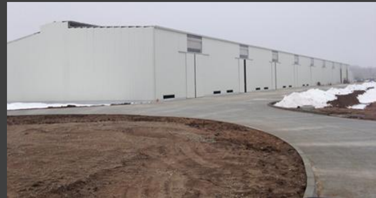
Execuție depozit de îngrășămintă - Periam.
