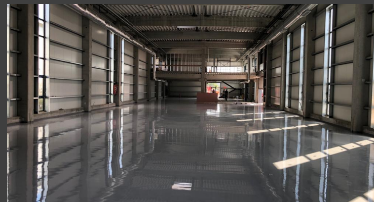
Construcție hală metalică - 853mp - Ghiroda, Timiș. - Panouri sandwich; - Tâmplarie cortină;
