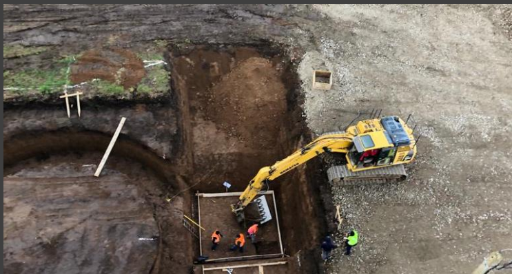
Lucrări de infrastructură – terminal feroviar - Sagu Arad
