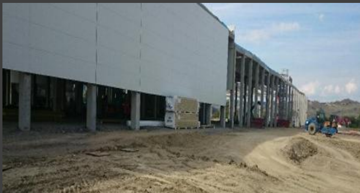
Asamblarea structurii prefabricate – Sighișoara. - Structură – 33000 mp;
