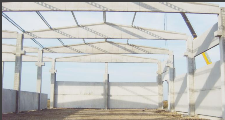
Asamblarea halei prefabricate Faist- Oradea dimensiunile halei - 3100 mp;
