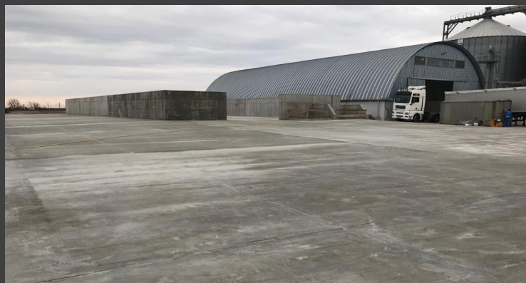
Hală de depozitare a cerealelor și platformă rutieră - Carani, Timiș
