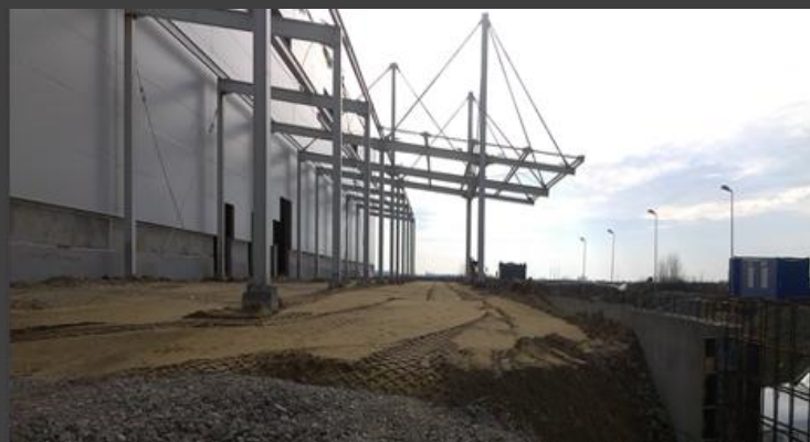
Terasamente, drumuri, garduri - Timișoara. - Lucrari de terasament - 14500 mp; - Lucrari rutiere: Drum colector (1200 mp), drumuri interioare (6650 mp), drumuri de serviciu (1600 mp);
