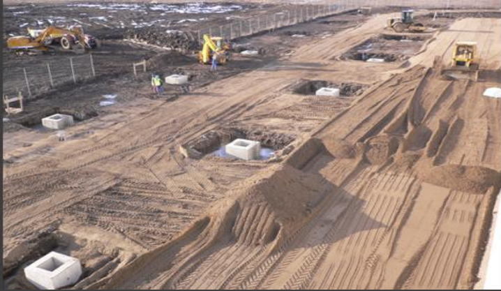
Proiectare și execuție infrastructură și suprastructură - 3200 mp - Timișoara
