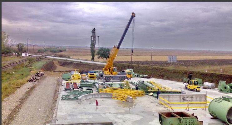
Proiectare și execuție fundații speciale pentru mășinarii, depozit și clădire de birouri, platforme de service și împrejmuire- Timișoara
