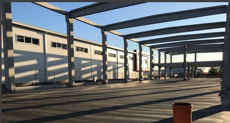
Lucrări de Infrastructură - depozitare și birouri - Ghiroda, Timiș
