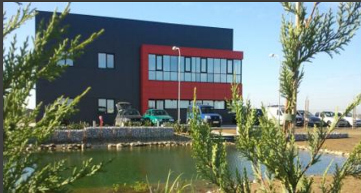
Construcția unei clădiri industriale, depozit și birouri - Timișoara
