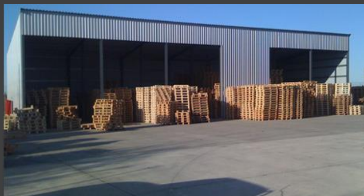
Proiectare și execuție depozit, lucrări de izolație - Timișoara
